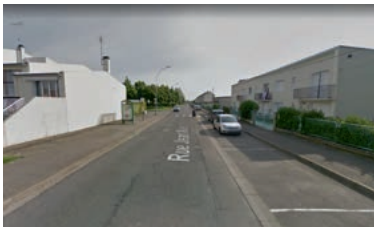
Rue Jean Macé avant les travaux
